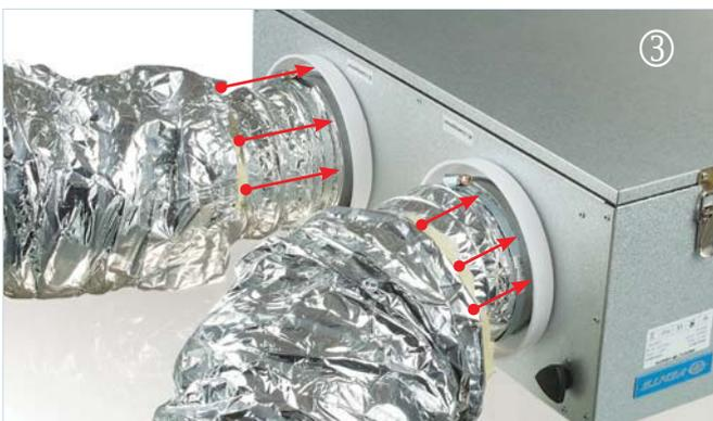
Verstecken Sie die Innen-Isolierungsschicht unter der Flansche von des Montagesatzes NM Isovent.
