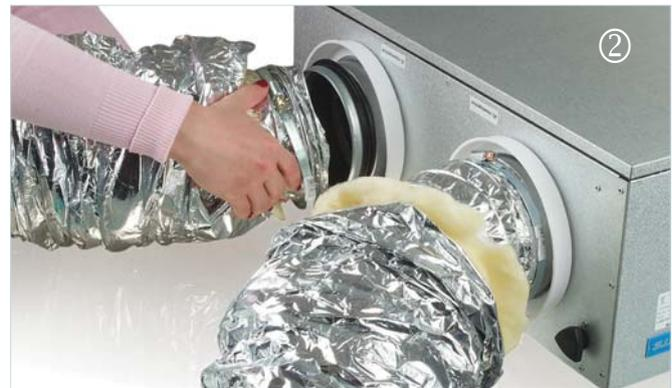
Bedecken Sie die Stutzen der Lüftungsanlage mit der Innenschicht der wärmeisolierten Lüftungsrohre und befestigen Sie diese mit Metall-Schlauchschellen (Sonderzubehör).
