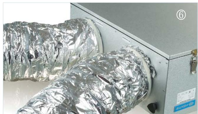
Jetzt sind die wärmeisolierten Lüftungsrohre mit den Stutzen der Lüftungsanlage zuverlässig verbunden.
