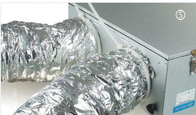
Ziehen Sie die Schlauchschellen am Verbindungspunkt der wärmeisolierten Lüftungsrohre mit den Flanschen des Montagesatzes NM Isovent fest.
