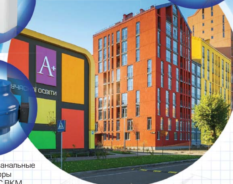
ЖИЛИЩНЫЙ КОМПЛЕКС «КОМФОРТ ТАУН» г. Киев, ул. Регенераторная, 4
