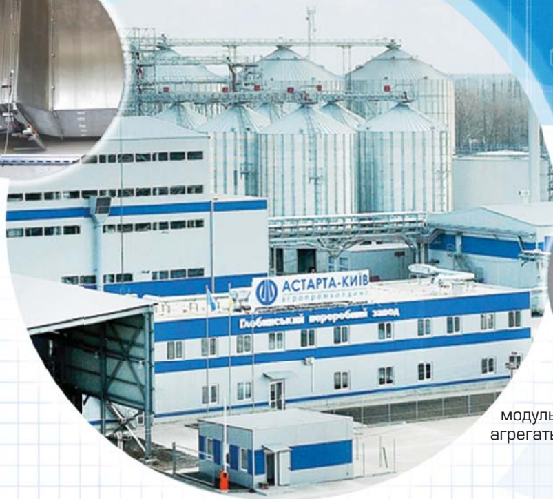
ГЛОБИНСКИЙ ПЕРЕРАБАТЫВАЮЩИЙ ЗАВОД г. Глобино, Полтавская обл.
