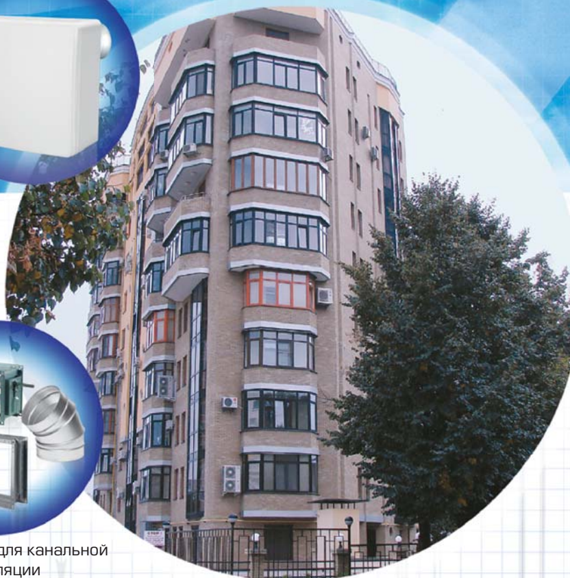
ЖИЛОЙ ДОМ г. Харьков, ул. Отакара Яроша, 18
