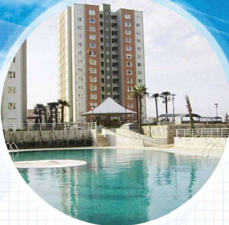
ЖИЛОЙ КОМПЛЕКС «SOYAK OLIMPIA KENT KONUTLAR» г. Стамбул, Турция
