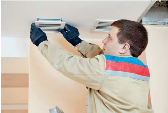
Рис. 50. Встановлення припливної решітки ОПГ 150*100 мм
