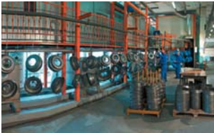
Цех порошковой покраски
