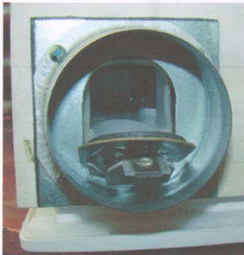
Рис. 1 Характерний вигляд електровентилятора ВНВ-1А 80 КП із зворотнім вогнезатримуючим клапаном у протипожежному корпусі КП 80
