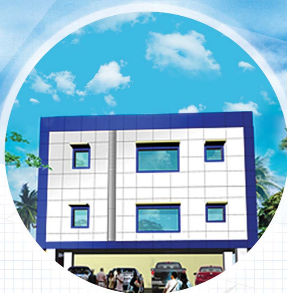
ЖИТЛОВИЙ БУДИНОК «ARUL CONSTRUCTION» м. Ченнаї, Індія
