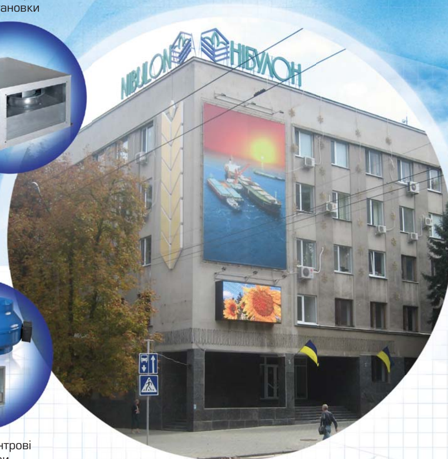
ОФІСНІ ПРИМІЩЕННЯ «НІБУЛОН» м. Миколаїв, вул. Велика Морська, 63
