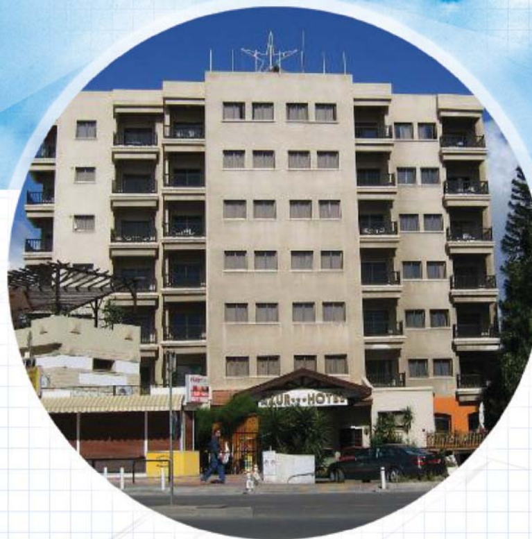
ГОТЕЛЬНИЙ КОМПЛЕКС «AZUR HOTEL» м. Лімасол, Кіпр
