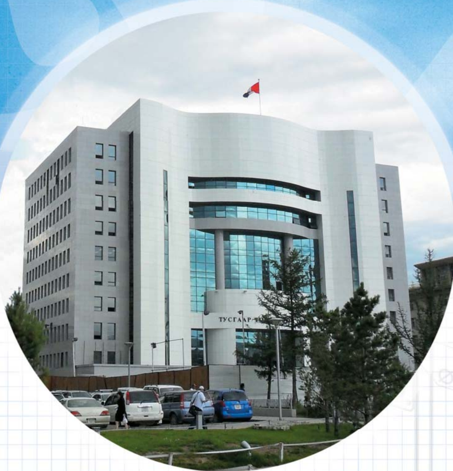
АДМІНІСТРАТИВНА БУДІВЛЯ «PALACE OF INDEPENDENT» м. Улан-Батор, Монголія
