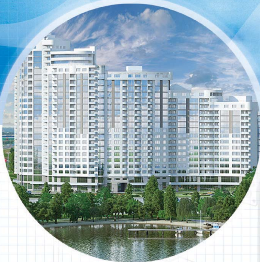
ЖИТЛОВИЙ КОМПЛЕКС «PARK STONE» м. Київ, вул. Героїв Сталінграда, 2 б
