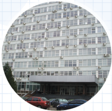
ОФИСНОЕ ЗДАНИЕ г. Донецк, ул. Челюскинцев, 291
