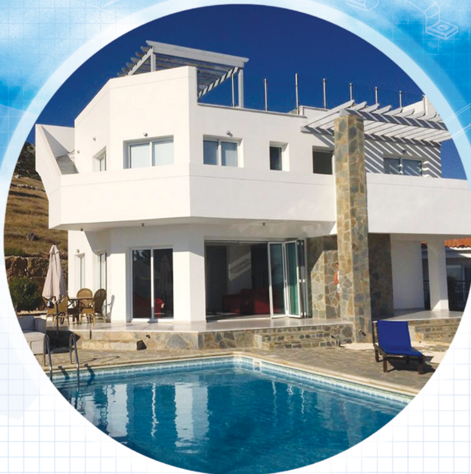
ЖИЛОЙ ДОМ «PEGIA VILLAS» г. Пафос, Кипр
